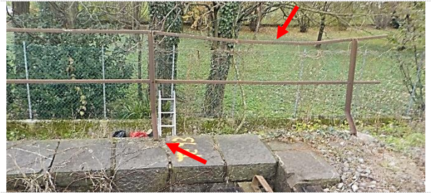
sl.8- poškodovana ograja na levem krilu opornika stran Sežana, deformacija ograje – označeno s puščicami
