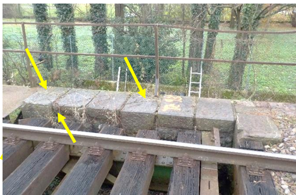
sl.21- kamni ograjnega venca na levem krilu stran Sežana: razpadle fuge med kamni, nekaj kamnov počenih
