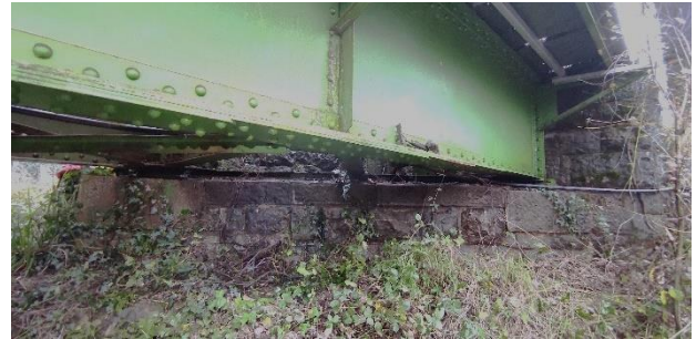
sl.16- opornik stran Sežana: lokalno bujno razraščanje vegetacije
