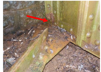
sl.14- korozija – odkorodiran končni del kraka kotnika nad ležiščem
