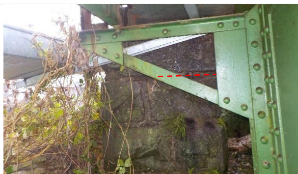
sl.35- opornik stran Jesenice: primer desnega krila / lokalne propadle fuge med kamni
