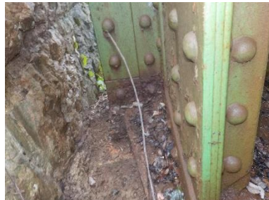
sl.13- močna korozija – del elementov konstrukcije nad ležiščem
