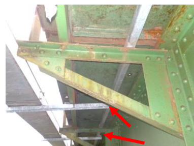
sl.29- konzole katere držijo inštalacijsko kineto so na nekaj mestih odpete iz konstrukcije/povešena kineta
