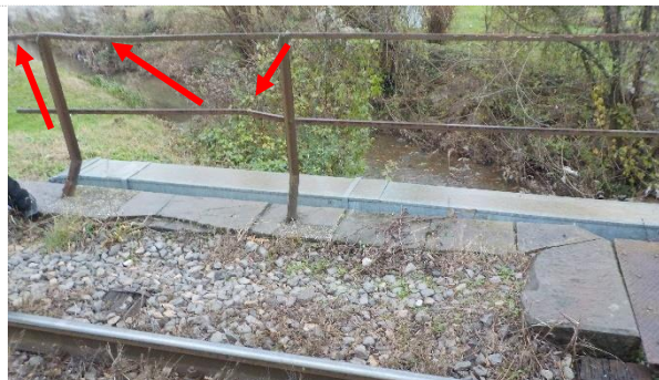
sl.6- poškodovana ograja na desnem krilu opornika stran Sežana, deformacija ograje – označeno s puščicami. Sanacija: DA
