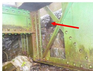
sl.44- razpoka v kamnitim bloku – čelna stena za zadnjim prečnikom / opornik stran Jesenice
