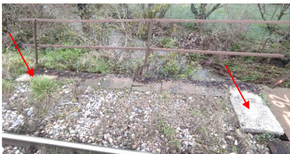
sl.36- opornik stran Jesenice: primer levega krila / ograjni venec – erodiran beton
