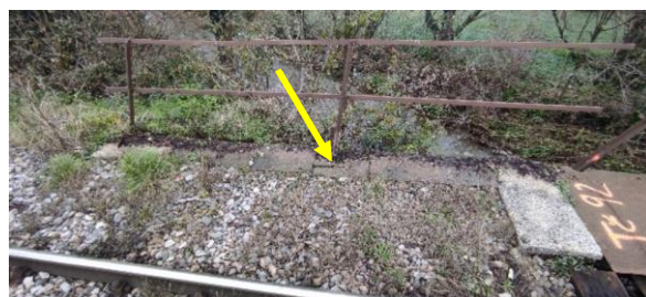
sl.41- opornik stran Jesenice: primer levega krila / ograjni venec – razpoke v kamnih ograjnega venca
