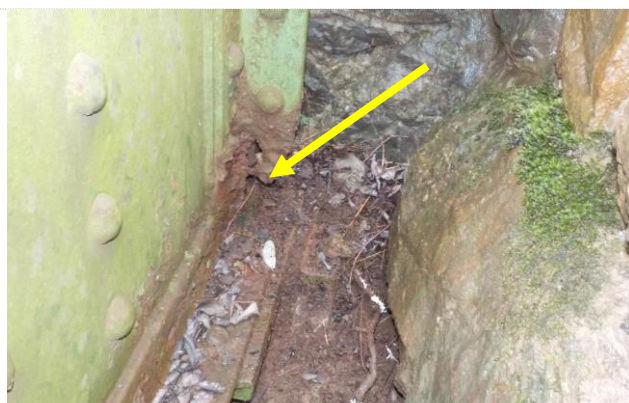
sl.26- pomično ležišče / sekundarni vzdolžnik stran Sežana/levo krilo – odkorodiran zaključek kraka kotnika nad ležiščem
