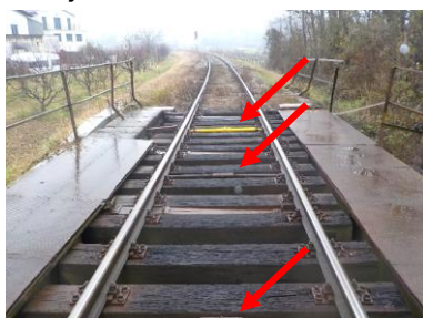
sl.28- dodatno vgrajene vezi za držanje distance med tirnicama/ nezadostna začasna rešitev
