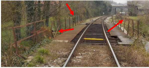
sl.7- poškodovana ograja na mostni konstrukciji, deformacija ograje – označeno s puščicami.
