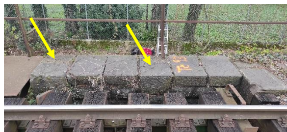
sl.39- opornik stran Sežana: primer levega krila / ograjni venec – razpoke v kamnih ograjnega venca
