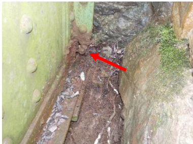
sl.12- korozija – odkorodiran končni del kraka kotnika nad ležiščem
