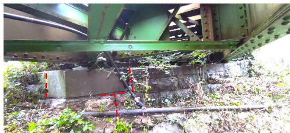
sl.31- opornik stran Jesenice: lokacije preperelih fug med kamni
