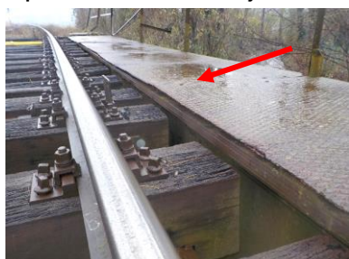
sl.27- pločevina je na strani naleganja na zgornjo pasnico glavnih vzdolžnih nosilcev slabo pritrjena/menjava z rešetkami
