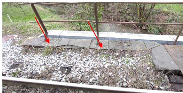
sl.37- opornik stran Sežana: primer desnega krila / ograjni venec – erodiran beton
