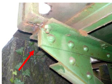
sl.42- razpoka v kamnitim bloku – ograjni venec / opornik stran Sežana – levo krilo
