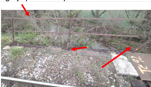
sl.5- poškodovana ograja na levem krilu opornika stran Jesenice, deformacija ograje – označeno s puščicami. Sanacija: DA
