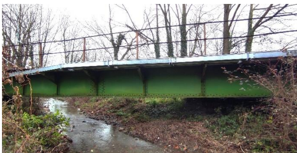
sl.1- gorvodni glavni polnostenski nosilec: ni ugotovljenih odstopanj / levi del slike: povešena inštalacijska kineta
