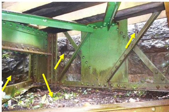
sl.19- čelna stena zaključka krila stran Sežana: razpadle fuge počen kamen, poraščenost z mahom, zablatenost police med ležišči
