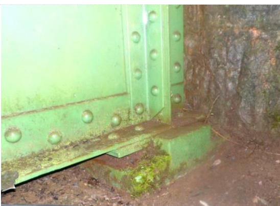
sl.25- pomično ležišče / glavni vzdolžnik stran Sežana/desno krilo
