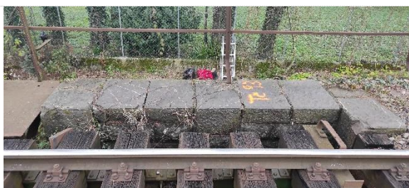
sl.32- opornik stran Sežana: primer levega krila / ograjni venec - propadle fuge med kamni / v celoti
