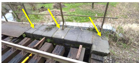
sl.40- opornik stran Jesenice: primer desnega krila / ograjni venec – razpoke v kamnih ograjnega venca
