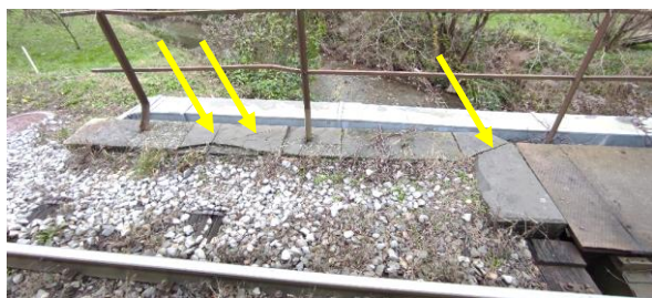
sl.38- opornik stran Sežana: primer desnega krila / ograjni venec – razpoke v kamnih ograjnega venca
