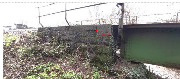
sl.33- opornik stran Sežana: primer levega krila / lokalne propadle fuge med kamni
