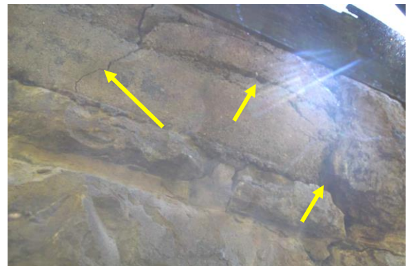
sl.20- čelna stena zaključka krila stran Jesenice: razpadle fuge, počen beton
