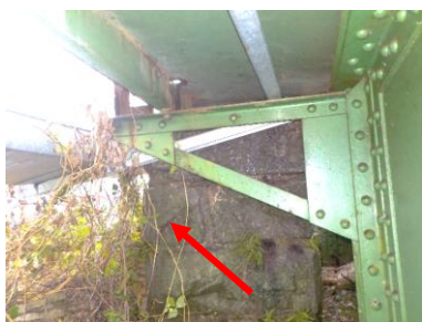
sl.43- razpoka v kamnitim bloku – čelna stena na desnem krilu / opornik stran Jesenice
