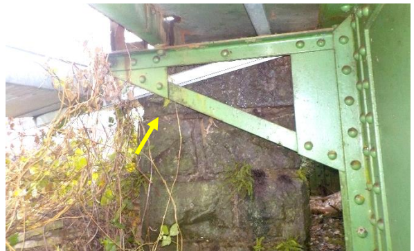
sl.18- desno krilo stran Jesenice: razpadle fuge med kamni, poraščenost z mahom
