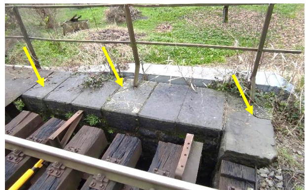
sl.22- kamni ograjnega venca na desnem krilu stran Jesenice: razpadle fuge med kamni, nekaj kamnov počenih
