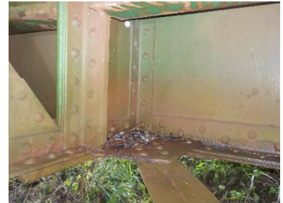
sl.11- lokalna korozija – priključne pločevine povežja v sp. pasu
