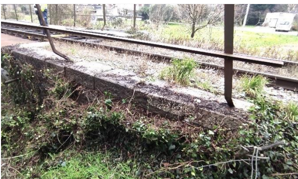
sl.34- opornik stran Jesenice: primer levega krila / ograjni venec - propadle fuge med kamni / v celoti
