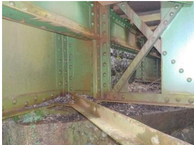
sl.9- lokalna korozija – površine nad ležiščno gredo
