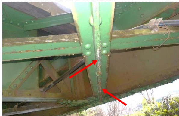
sl.4- horizontalno vzdolžno povezje na spodnji strani glavnih vzdolžnih nosilcev: lokalno deformirani kraki kotnikov sestavljenih vezi (korozija) Sanacija: PKZ
