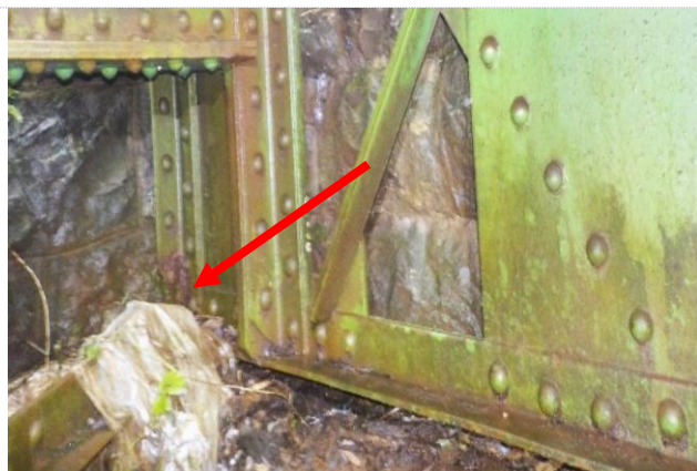
sl.24- pomično ležišče / sek. vzdolžnik stran Jesenice/desno krilo/ odkorodiran zaključek kraka kotnika nad ležiščem
