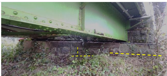
sl.30- opornik stran Sežana: lokacije preperelih fug med kamni
