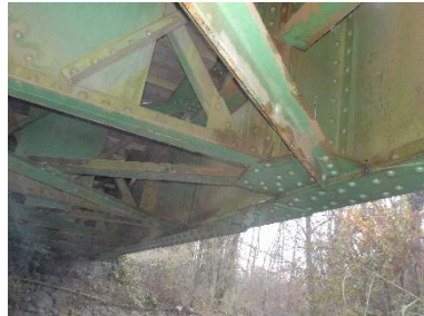
sl.10- lokalna korozija – elementi povežja glavnih nosilcev v sp. pasu
