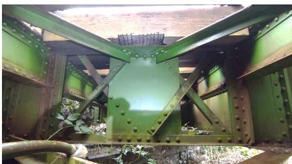
sl.3- pogled na premostitveno konstrukcijo z notranje spodnje strani (prečnik, vzdolžnika): bistvenih odstopanj ni ugotovljenih
