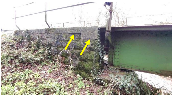
sl.17- levo krilo stran Sežana: razpadle fuge med kamni, poraščenost z mahom
